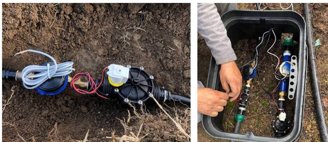
Figura 13.- Fotografía detalle de la instalación de la electroválvula y contador.
