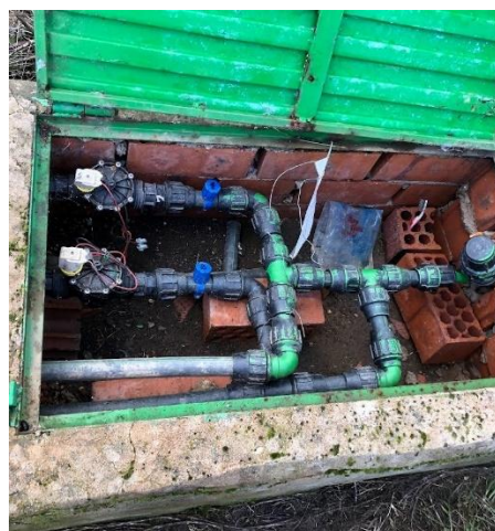
Figura 8.- a) Depósito y placa solar de la parcela 2 de Casas del Castañar. b) Arqueta del cabezal de riego. Visita realizar con los técnicos y agricultores para comprobar cobertura y diseñar la instalación de riego.
